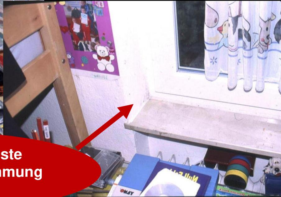
**Hier ist immer der kälteste Punkt bei einer Außendämmung innen.**
