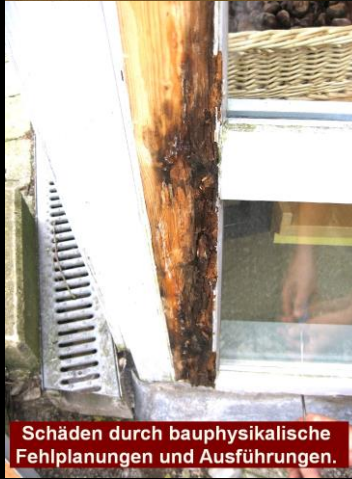
Eklantante Schäden aus fehlenden Bauwerksabdichtungen.
