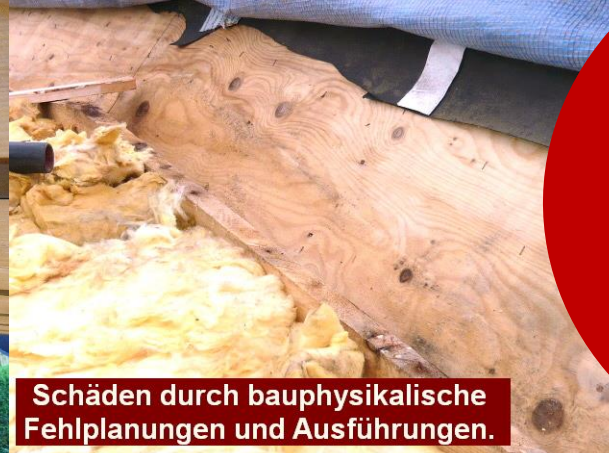
Wasserschäden bei Holzkonstruktionen aus fehlenden Bauwerksabdichtungen.
